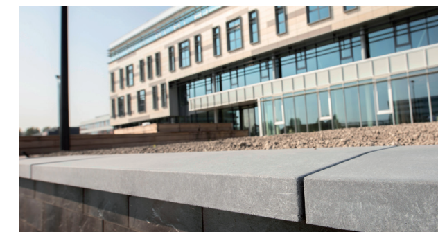
Die beiden killosen Mauerabdeckungselemente passen einfach ineinander und die Dilatationsfuge muss nicht abgekittet werden.
